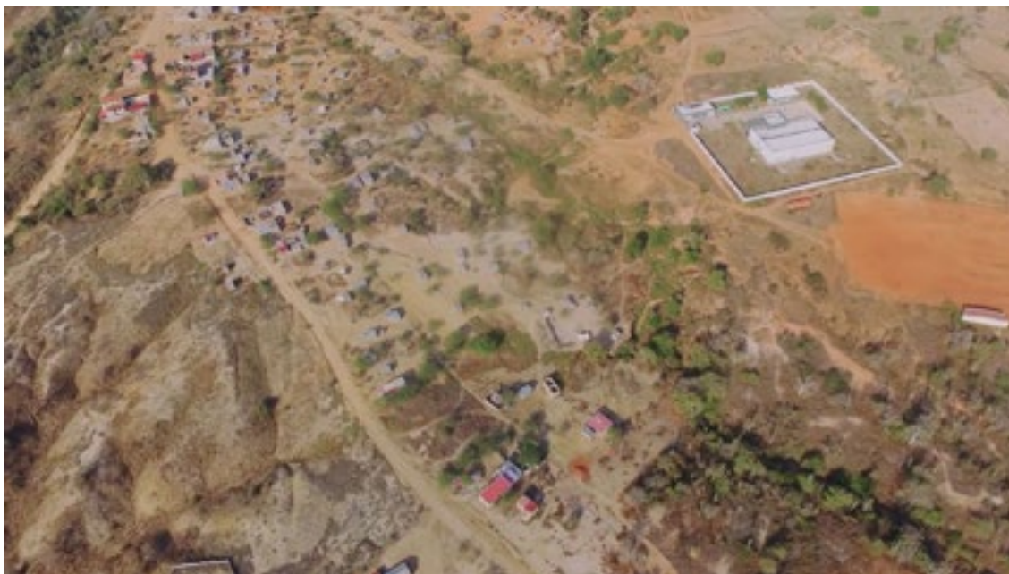
Figura 4 – Registro aéreo da estação de cabo submarino da Angola Cables e comunidade circunvizinha
