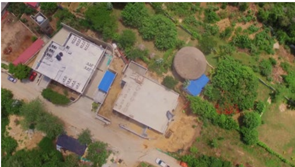
Figura 7 – Estação e data center em Salgar
