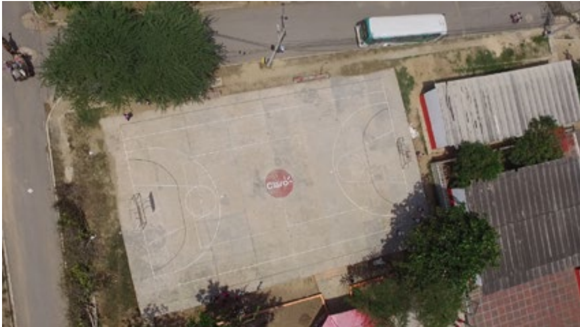
Figura 6 – Escola vizinha à estação de cabo submarino em Salgar
