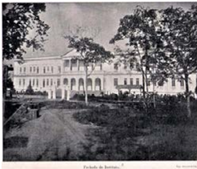
Figura 4 – Fachada do Instituto Lauro Sodré, atual Tribunal de Justiça do Estado
