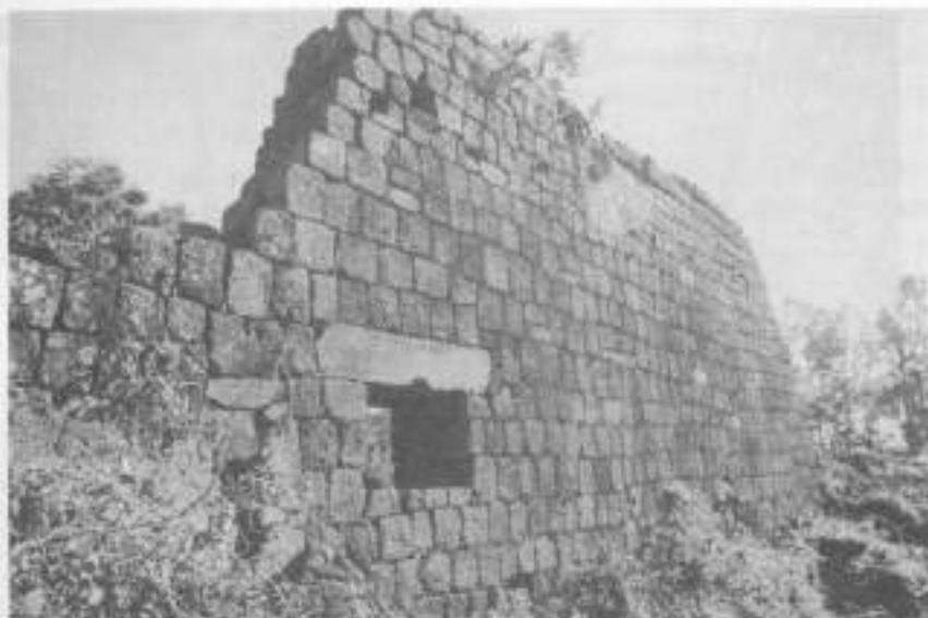
Remanescentes arquitetônicos da Missão de São Lourenço Mártir — Paredes que separam o refeitório da cozinha na Residência dos Padres. (Foto: Artur Barcellos)
