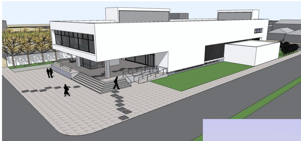
Figura 20: Perspectiva externa. Av. Darci Azevedo com Av. Ver. Osvaldo Bins Fonte: Autora (2010)
