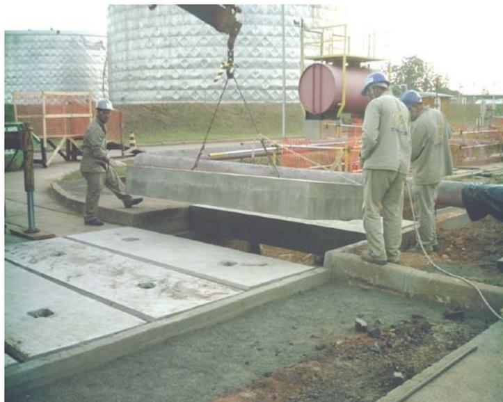
**Figura 14** – Instalação de placas pré-moldadas nas travessias.
