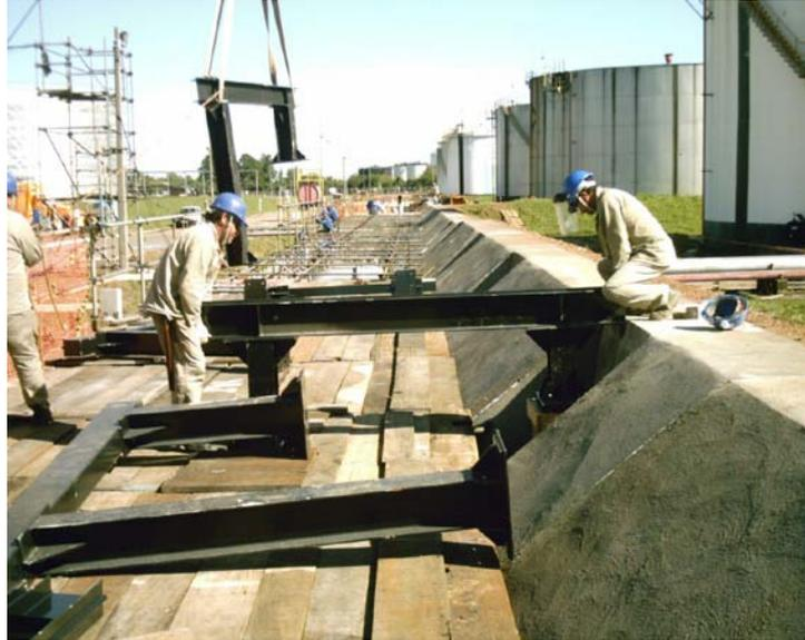
**Figura 13** – Montagem de *Pipe-Rack*.
