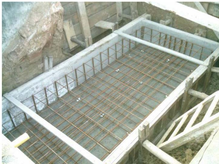
**Figura 12** – Exemplo da forma e armadura das bases em estudo.
