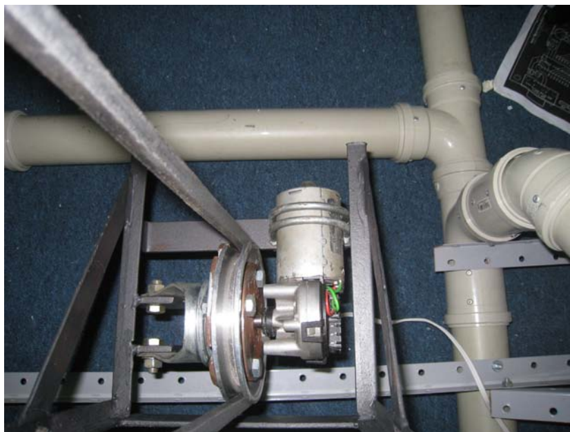
Figura 6: Motor montado na torre Pitch
