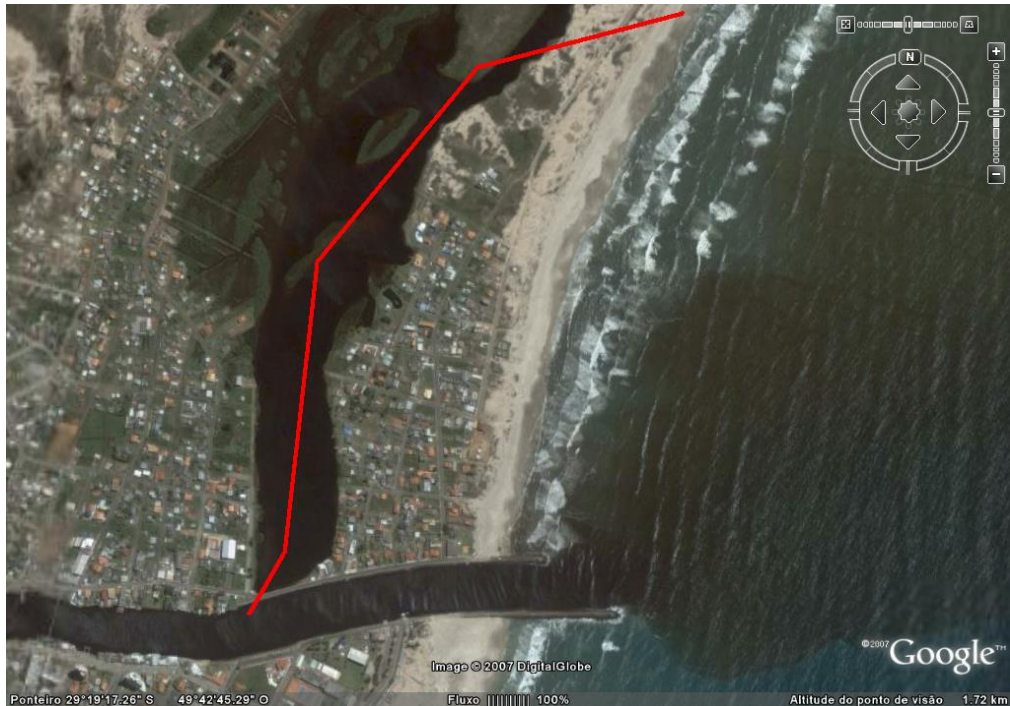
Figura 11 - Imagem da barreira arenosa, antigamente pertencente ao RS e que após a obra passou a fazer parte de SC. Hoje a barreira arenosa esta amplamente urbanizada (Pasárgada).
