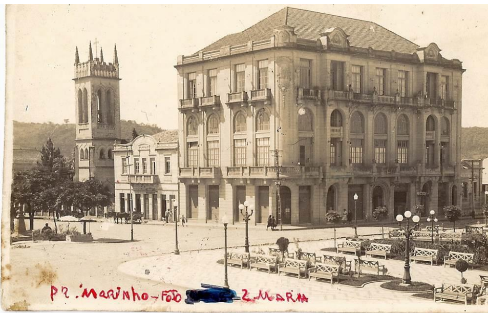
Fotografia 6: Prédio da Sociedade União dos Caixeiros Viajantes.
