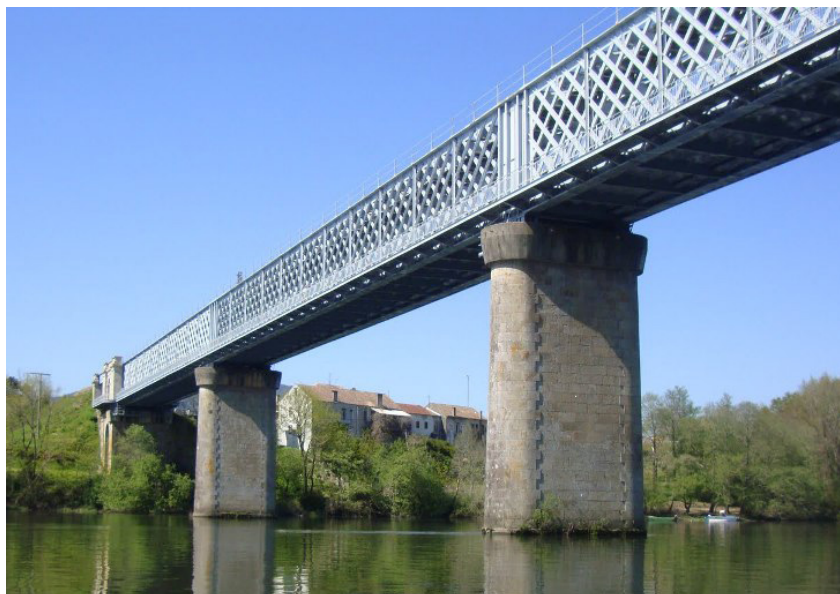
Figura 3 – Ponte entre as cidades de Tui e Valença
