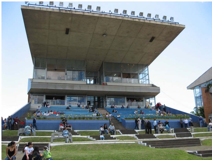
Figura 9 - Estrutura do 3º Pavilhão do Hipódromo do Cristal Fonte: www.google.com.br , 2009.
