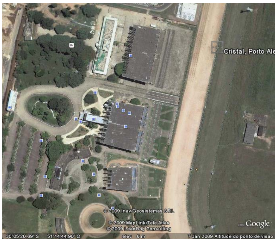
Figura 10 - Vista aérea parcial do Hipódromo do Cristal - Pavilhões Fonte: Google Earth, 2009.
