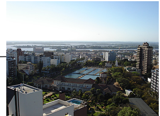
Figura 1: Vista aérea da Hidráulica
