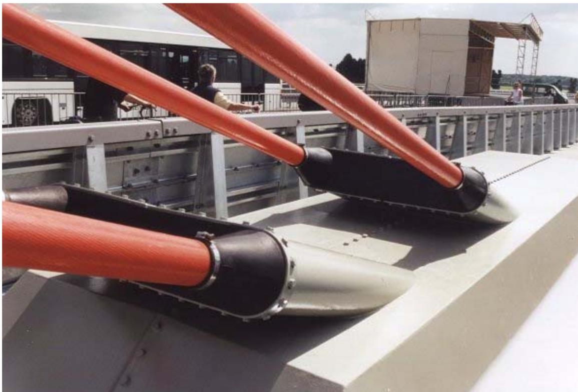
Figura 5 - Detalhe da ligação cabo tabuleiro na ponte Ilverich
