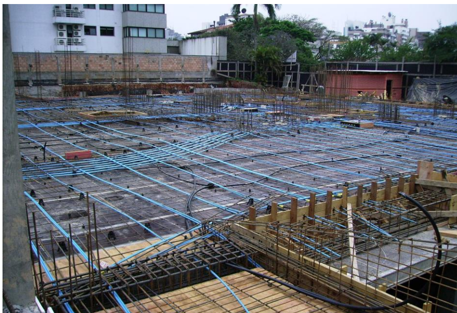
Posicionamento e montagem dos cabos de protensão na laje do pavimento tipo do empreendimento B. Fonte: Engenheiro Matheus S. Bittencourt (2010).
