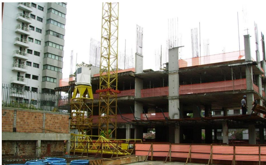
Aspecto dos pilares do pavimento tipo do empreendimento B, após a execução da concretagem. Fonte: Engenheiro Matheus S. Bittencourt (2010).
