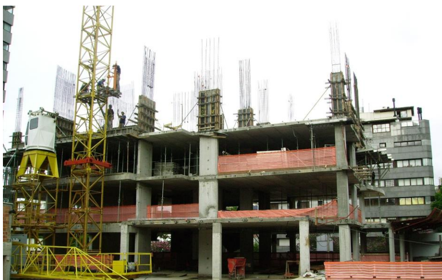
Montagem das armaduras dos pilares do pavimento tipo do empreendimento B em lances duplos. Fonte: Engenheiro Matheus S. Bittencourt (2010).
