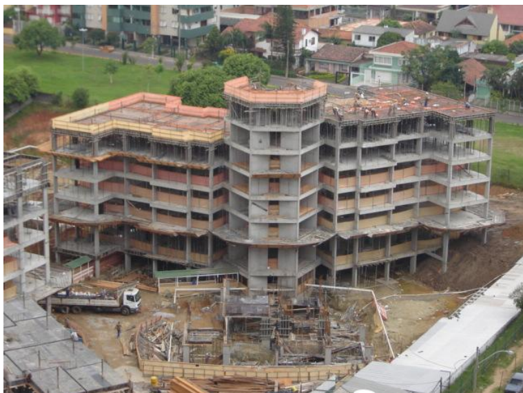
Vista superior de uma das torres constituintes do empreendimento A. Fonte: Construtora responsável pela execução do empreendimento A (2010).
