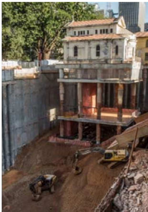
Figura 3 – Capela “suspensa” para a construção dos subsolos
