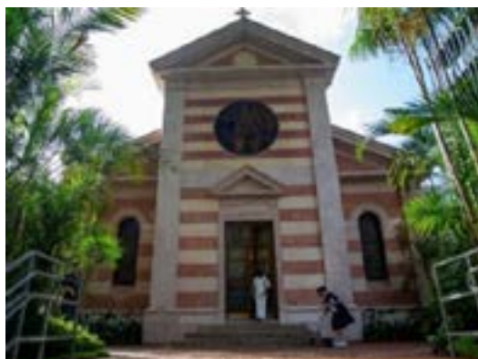
Figura 5 – Fachada da capela depois do restauro
