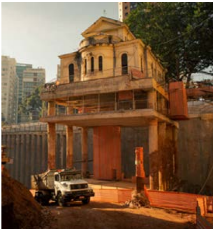
Figura 1 – Capela do Hospital Matarazzo "suspensa" para a construção dos subsolos
