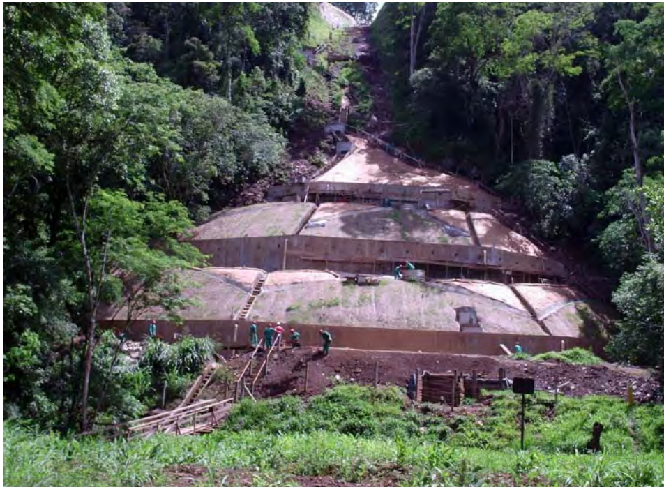
Figura 14 – Estrutura para a estabilização da encosta em processo de movimentação com risco à integridade de dutos
