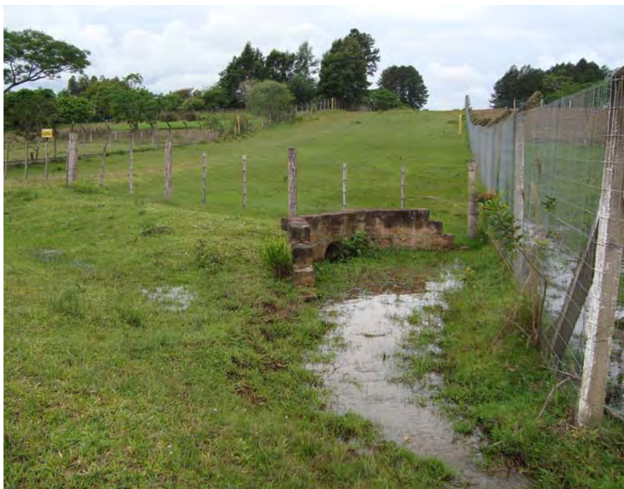
Figura 23 – Dreno implantado em região alagadiça do trajeto da dutovia OSCAN Fonte: o autor (2008)
