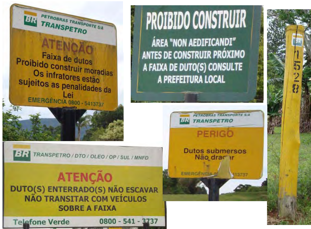
Figura 28 – Placas de sinalização da dutovia OSCAN e poste de madeira com a numeração da PETROBRAS Fonte: o autor (2008)
