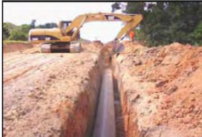
Figura 8 – Duto Subterrâneo Fonte: Petrobras (2007b, p.20)
