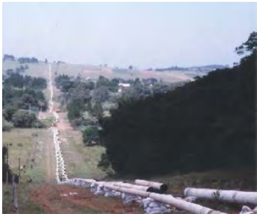
Figura 17 – Implantação de duas novas linhas de dutos: OSCAN II 8” e 16” Fonte: GDK S.A. ([2008])
