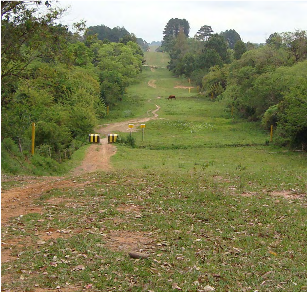
Figura 20 – Trecho da dutovia OSCAN no qual fica evidenciada a remoção de vegetação arbórea original Fonte: o autor (2008)
