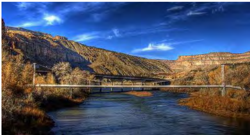
Figura 7 – Duto aéreo (rio Colorado, Colorado, EUA) Fonte: www.Bridgepix.com ([2008])
