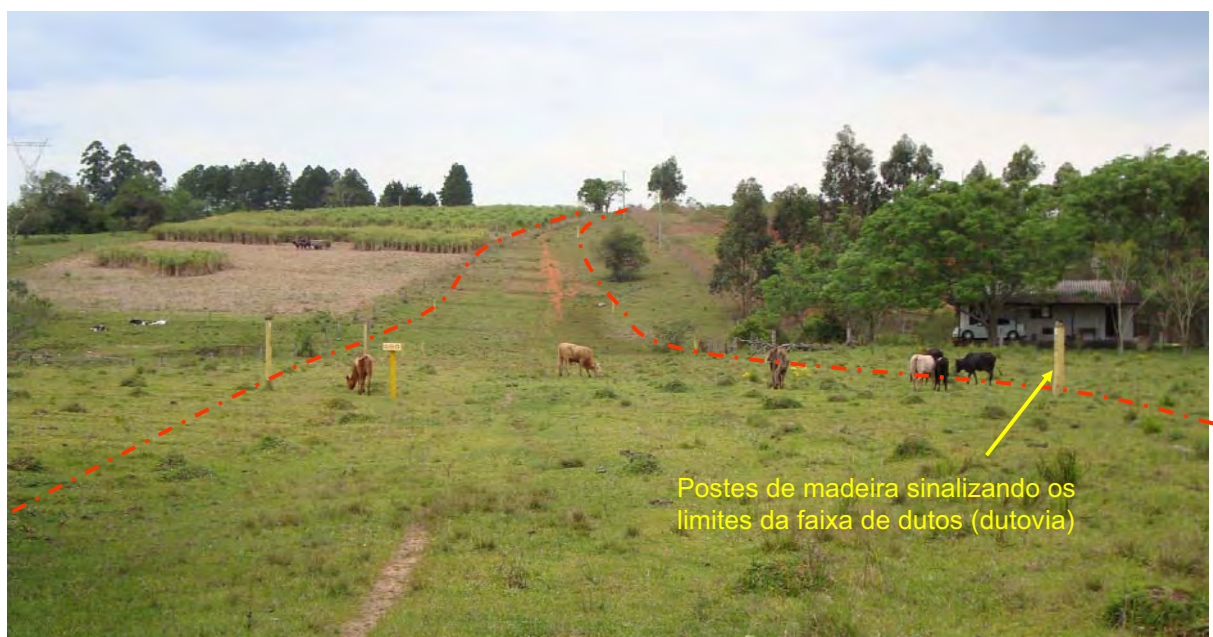
Figura 27 – Dutovia OSCAN sinalizada por postes amarelos dentro de uma propriedade com passagem livre do gado sobre a pista
