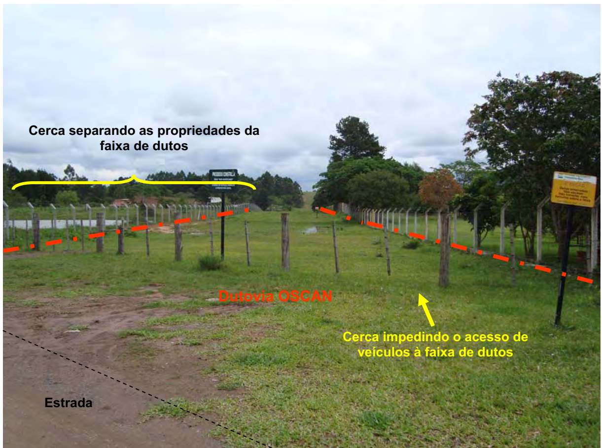
Figura 26 – Proteção e sinalização da dutovia OSCAN na sua intersecção com estrada no loteamento Cadiz Fonte: o autor (2008)
